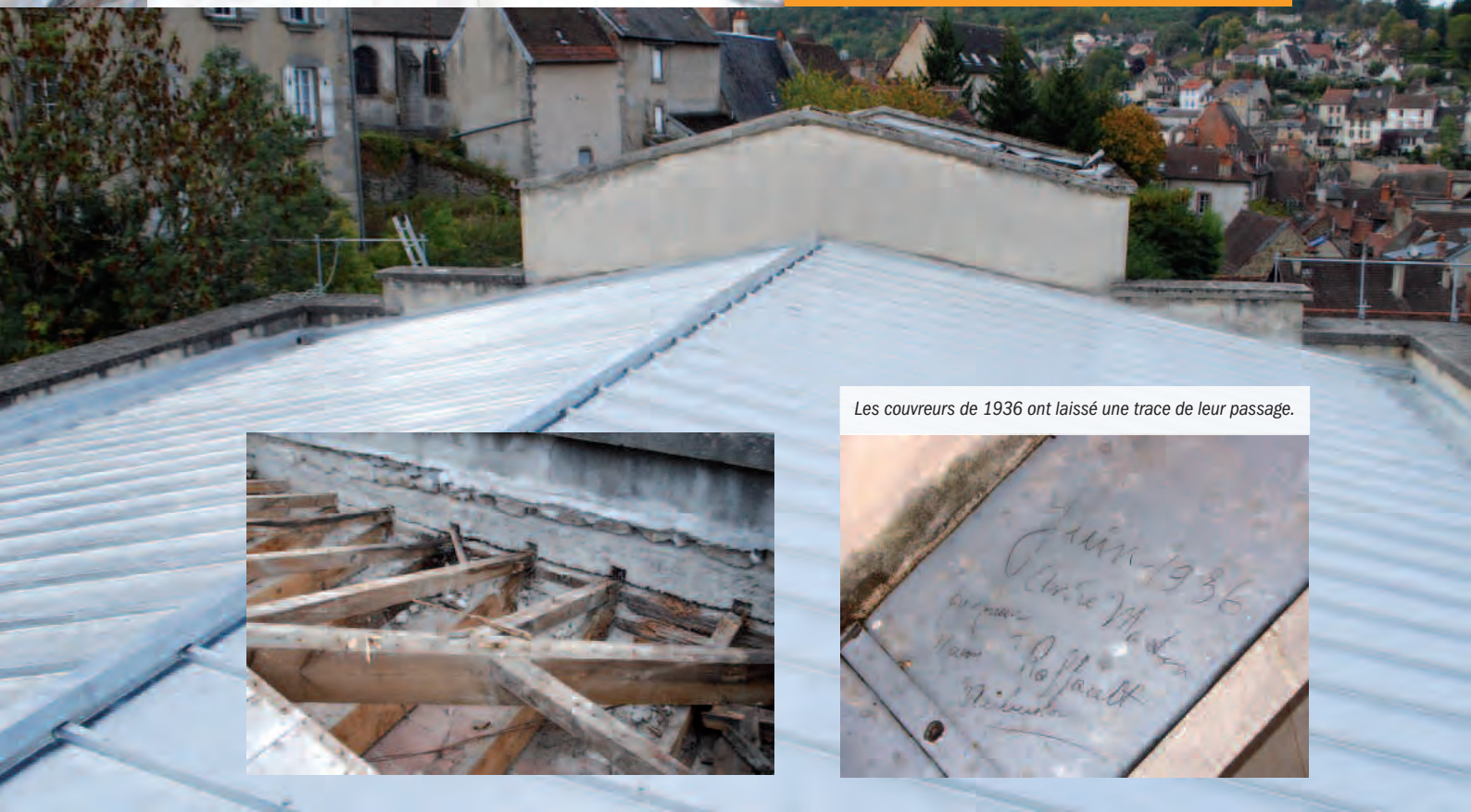
Stephan Morice, et Alexandre Navarro, ici avec Christophe Nablanc, directeur des services techniques de la ville, ont passé des centaines d'heures sur les toits de la mairie d'Aubusson.
