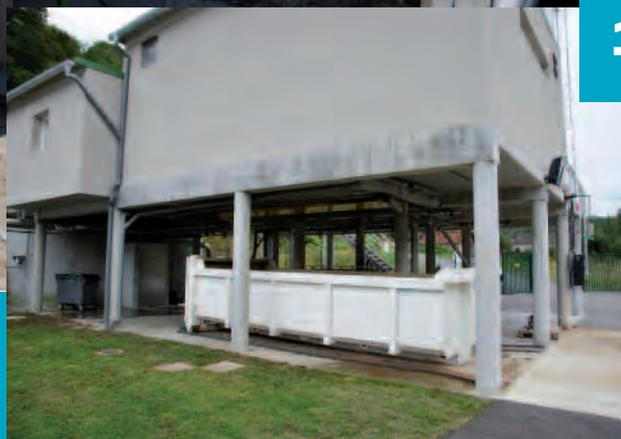
Sous le local technique, un container réceptionne les retours de boues du filtre-pressé situé dans le local au dessus. .
