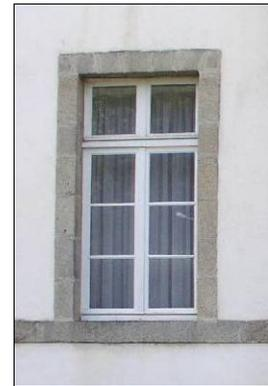
Fenêtres à grands carreaux, 3 carreaux par vantail, imposte fixe. (Lycée)
