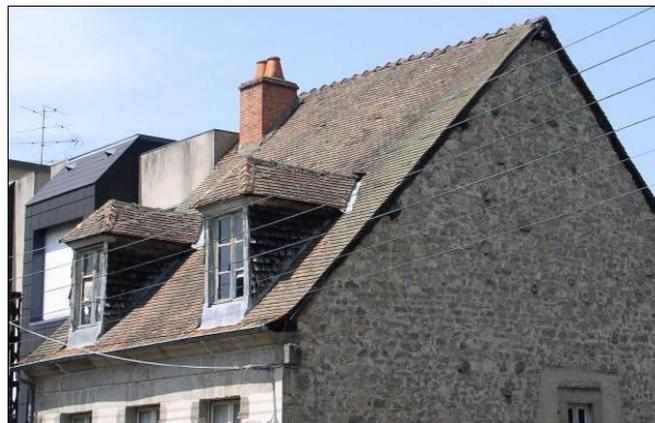
Rive en tuiles plates, débordant sur le chevron apparent.
