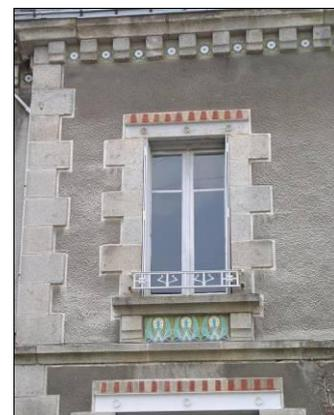
*Jambages et appuis en pierre de taille, linteau métallique, avec un rang de brique au-dessus du linteau, faïence sur l'allège.*
