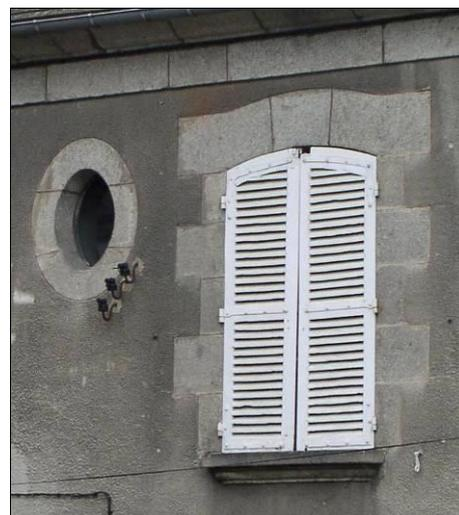
2. Lorsqu'il n'y a pas de cadre en ressaut autour des baies, un cadre rectiligne ou un contour harpé régulier peut être tracé dans l'enduit.
