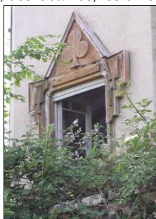
Encadrement de baie en bois, fronton triangulaire contenant un trèfle.
