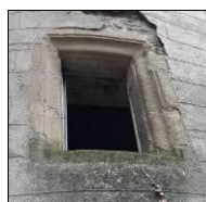
26 rue Châteaufavier. Mouluration en doucine avec filets.
