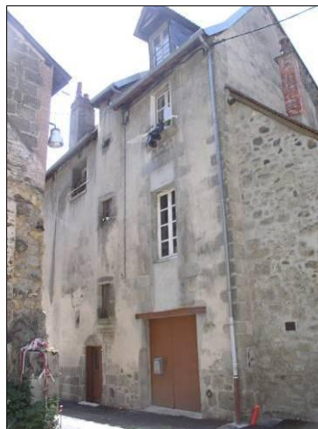
Maison rue Basse Terrade. Vis dans-œuvre, l'escalier est signalé par un léger encorbellement en façade et par ses petites fenêtres décalées, comme au 83 Grande rue.
