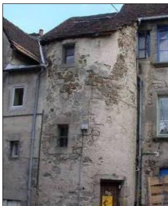
Quartier de la Terrade. Tour d'escalier en maçonnerie enduite, comme le reste de la façade.
