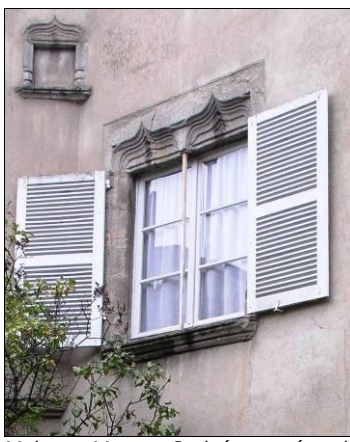
Maison Mage. Croisée ornée de deux accolades. Le meneau a été supprimé.
