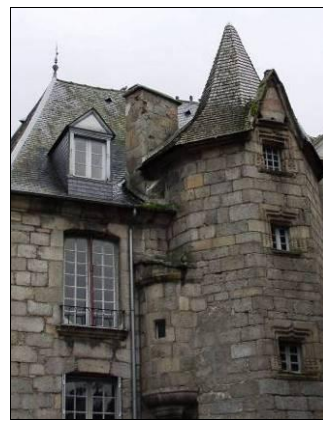
Maison Vallenet : tour d'escalier polygonale en pierre de taille.
