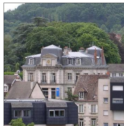
Toitures à pente brisée, terrasson couvert en zinc, brisis en ardoises.
