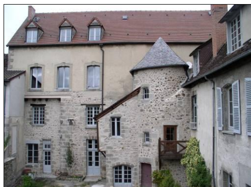
24 et 26 rue Châteaufavier : ces deux maisons aux façades XVIIIe (1765 et 1772) ont abrité des ateliers de tapisseries. La surélévation d'un étage en brique au n°24 (à gauche) est liée à cet usage.
