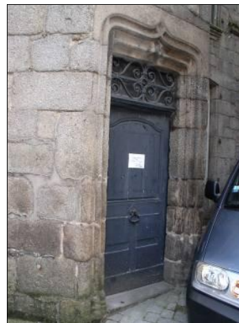
Porte d'entrée de l'escalier, maison Vallenet.
