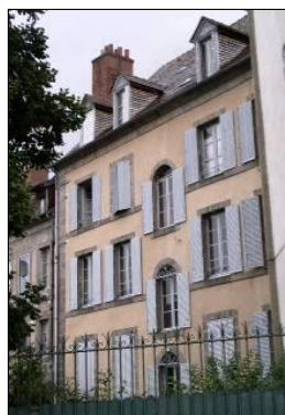
1 rue des Déportés. Façade arrière en moellon enduit, sur rue en pierre de taille.
