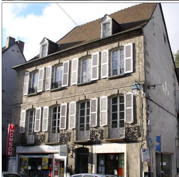
75 Grande rue. Quatre portes-fenêtres au premier étage, garde-corps de balcons en fer forgé.
