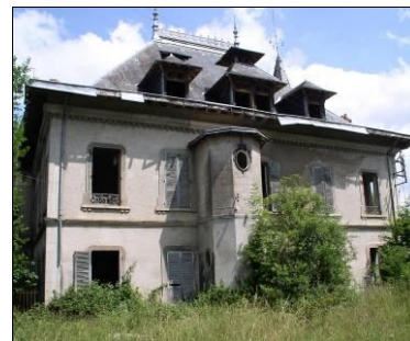
Façade arrière, sur cour des communs.
