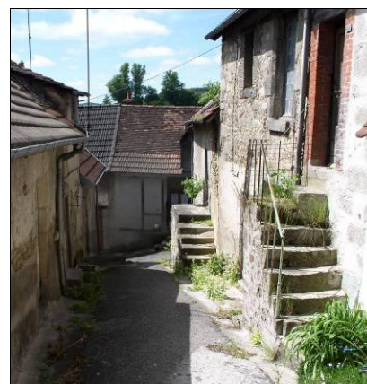
Escaliers extérieurs, rue des Caquelaquets
