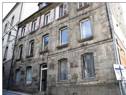
24 et 26 rue Châteaufavier : ces deux maisons aux façades XVIIIe (1765 et 1772) ont abrité des ateliers de tapisseries. La surélévation d'un étage en brique au n°24 (à gauche) est liée à cet usage.
