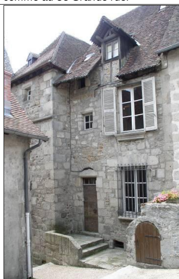
Maison Corneille, façade sur la rue de la Roche. Vis dans œuvre, sans encorbellement en façade.
