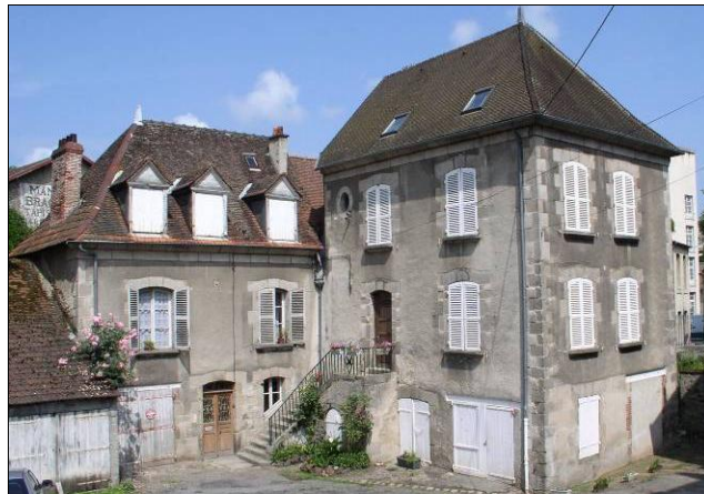
Façade côté rue, en contrebas de l'avenue de la République
