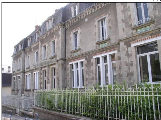
Ecole primaire Villeneuve, rue Dumazet
