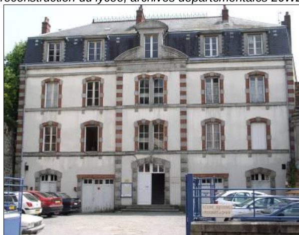
Ecole primaire Jean Maçé Construite à l'emplacement d'un grand hôtel, Laboreys de Châteaufavier, qui faisait face au n°15 rue Châteaufavier.
