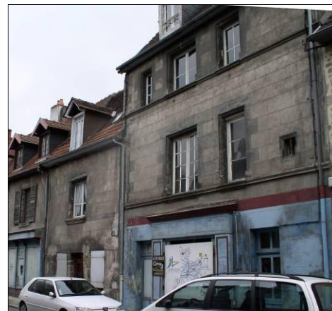
Maison 10 rue Jules Sandeau
