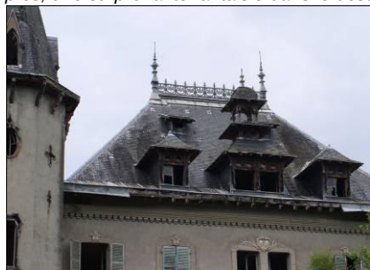
Lucarne central à trois niveau de toiture, le dernier formant un clocheton.
