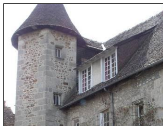
24 rue Châteaufavier. La tour hors-œuvre, s'élève d'un niveau supplémentaire au-dessus de l'escalier en vis.
