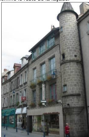
Maison Rogier, 74 Grande rue. Tourelle d'angle en encorbellement, en pierre de taille, 3 niveaux.
