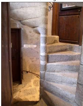
Maison Corneille : l'escalier. Les trois pièces desservies sont à des niveaux décalés.
