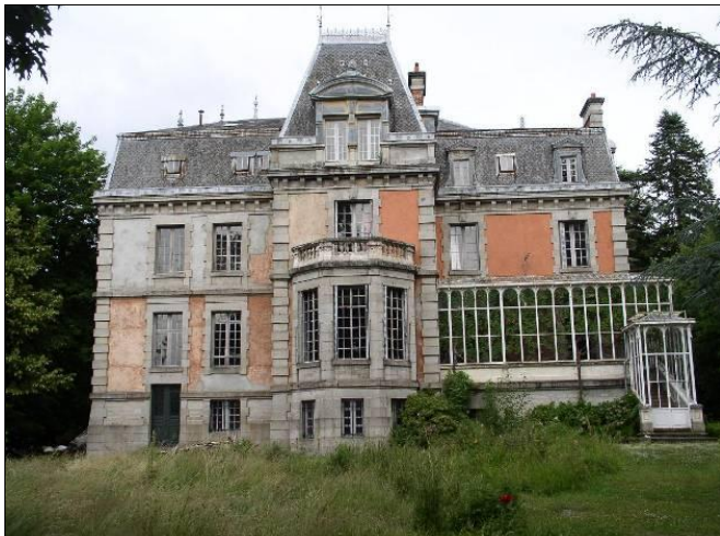
Façade arrière avec véranda.
