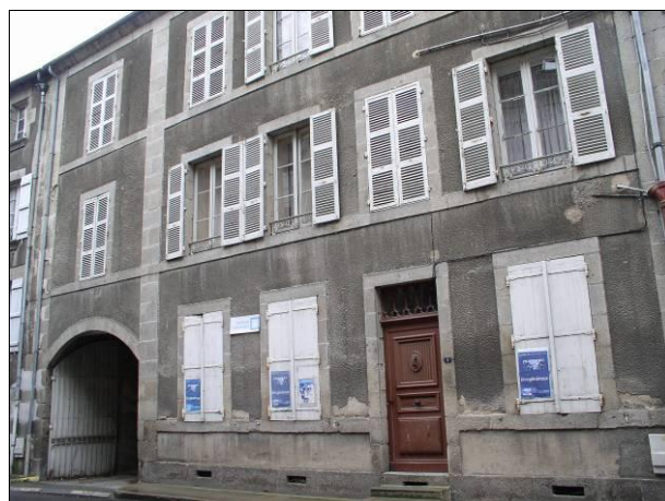
4 rue Jean Jaurès. Ancienne minoterie.
