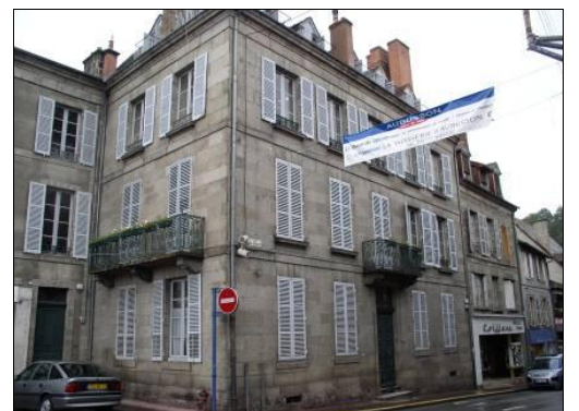
1 rue des Déportés. Façade arrière en moellon enduit, sur rue en pierre de taille.
