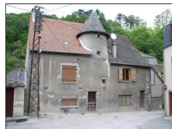
Maison rue Basse-Terrade. Vis dans-œuvre, dépassant d'un niveau au-dessus de l'égout du toit.
