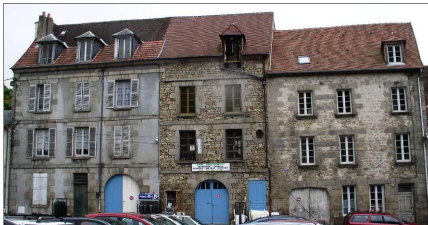
Place du marché. Immeubles XVIIIe siècle, avec entrepôts au rez-de-chaussée
