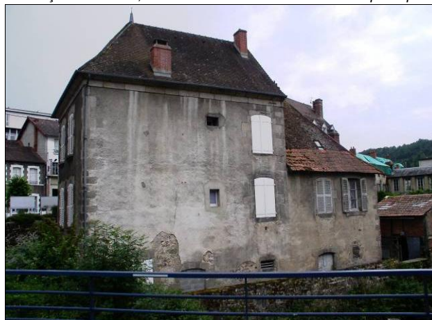
Façade arrière, donnant sur la Beauze.
