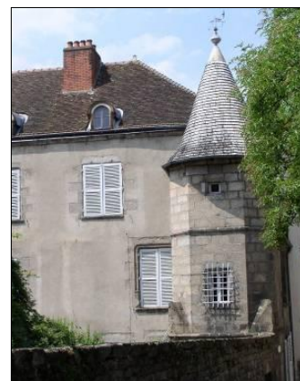
Maison Mage. Tour d'angle de plan carré au rez-de-chaussée, puis octogonal dans les étages.
