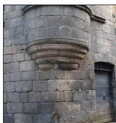
Maison Vallenet, détail
